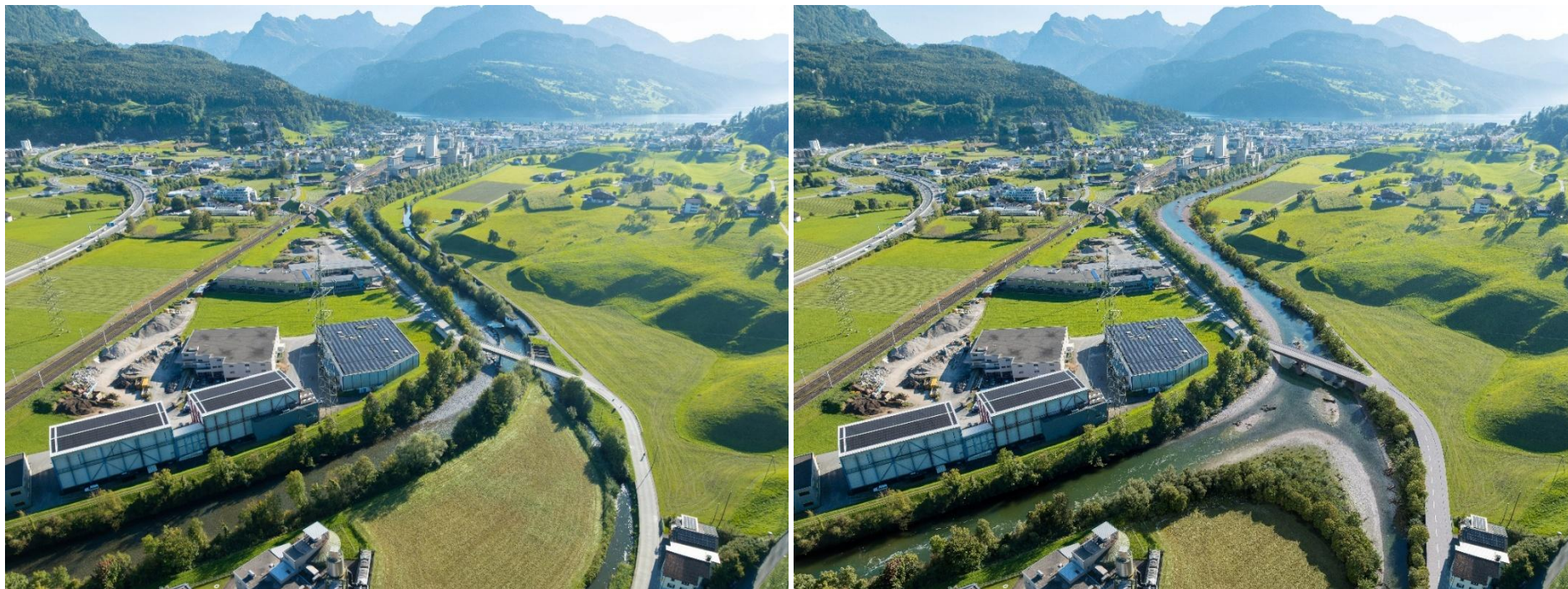
Abbildung 1: Luftbild Zusammenfluss Muota und Seeweren mit aufgeweitetem Mündungsbereich und neuer Langenstegbrücke
