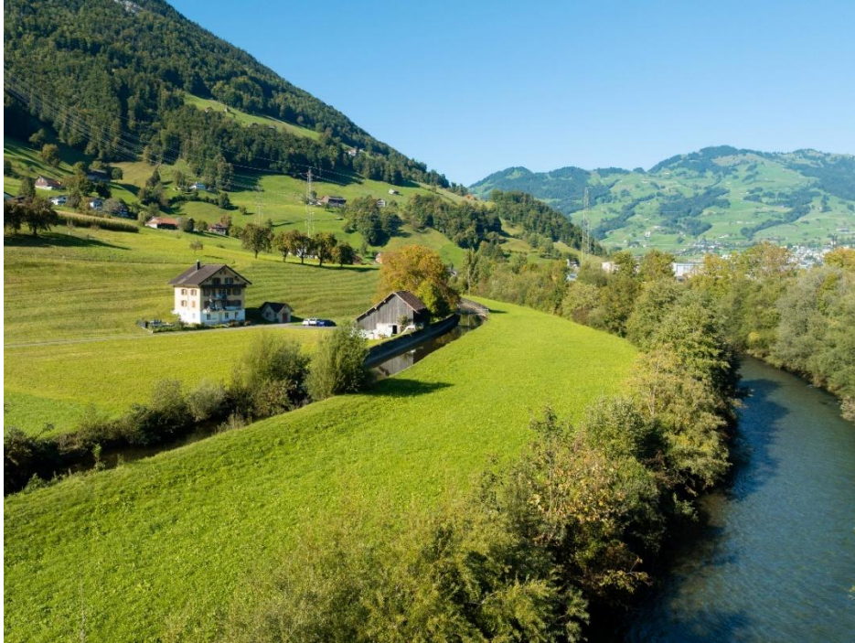
Abbildung 2: Aufweitung Muota mit dynamischen Kiesinseln und Kiesbänke sowie neuem Dammweg entlang des rechten Ufers
