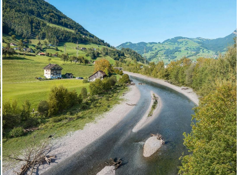
Abbildung 2: Aufweitung Muota mit dynamischen Kiesinseln und Kiesbänke sowie neuem Dammweg entlang des rechten Ufers
