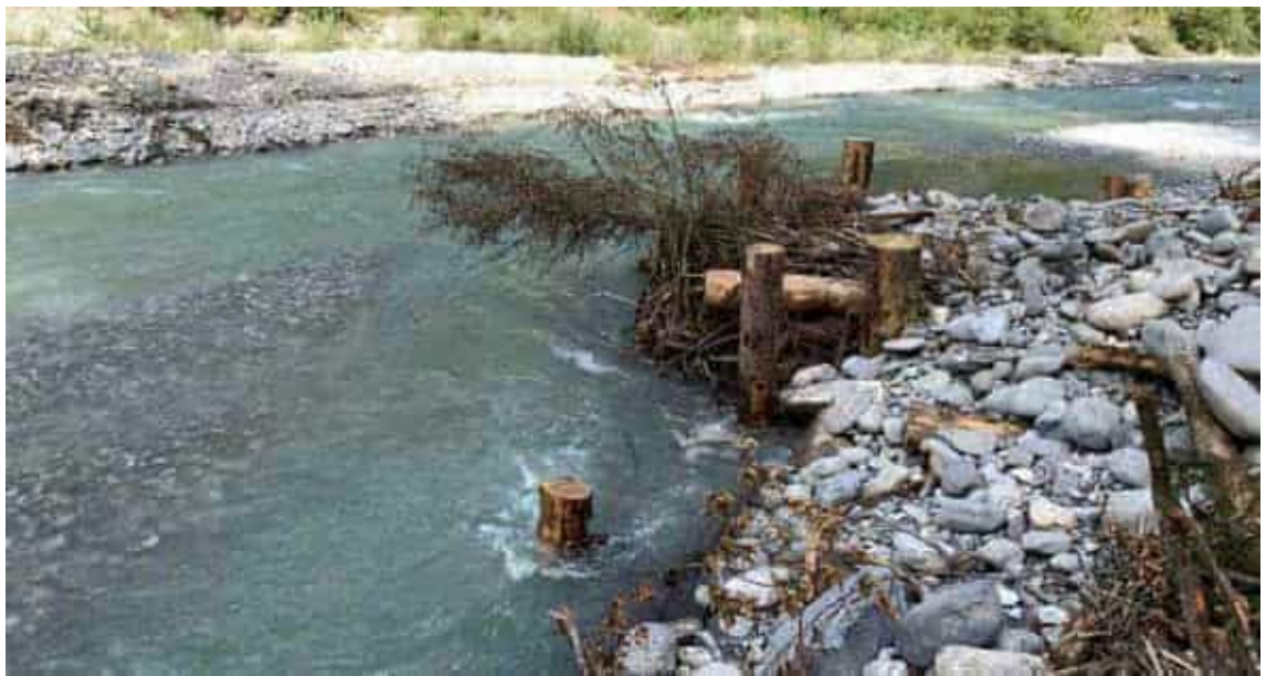
Abbildung 62: In Blockwurf integrierter Holzkasten, Foto, Simme Wimmis (Ausführung 2023), K+Z AG
