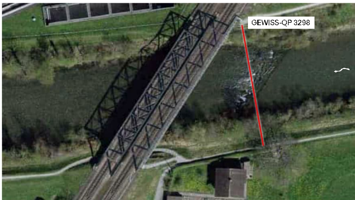
Abbildung 46: Schwelle zur Sicherung des ARA-Kanals bei GEWISS-QP 3298
