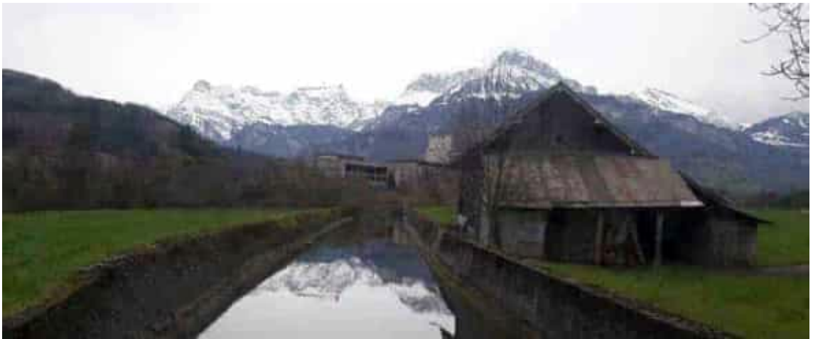
Abbildung 15: landwirtschaftliches Gebäude direkt am rechten Ufer des Oberwasserkanals zwischen Gewässernr. 2642 und 2527, Foto: K+Z AG
