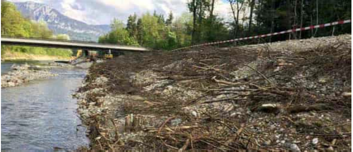
Abbildung 56: Blocksatz mit vorgelagerter BMU direkt nach dem Einbau. Foto: Projekt HWS Emme Solothurn, PG Bau
