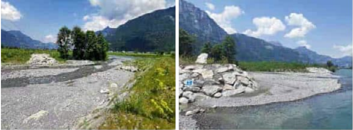
Abbildung 64: Beispielbild aufgeweitete Mündung Palanggenbach bei Seedorf/ Attinghausen bei der Einmündung in die Reuss, Foto: K+Z AG
