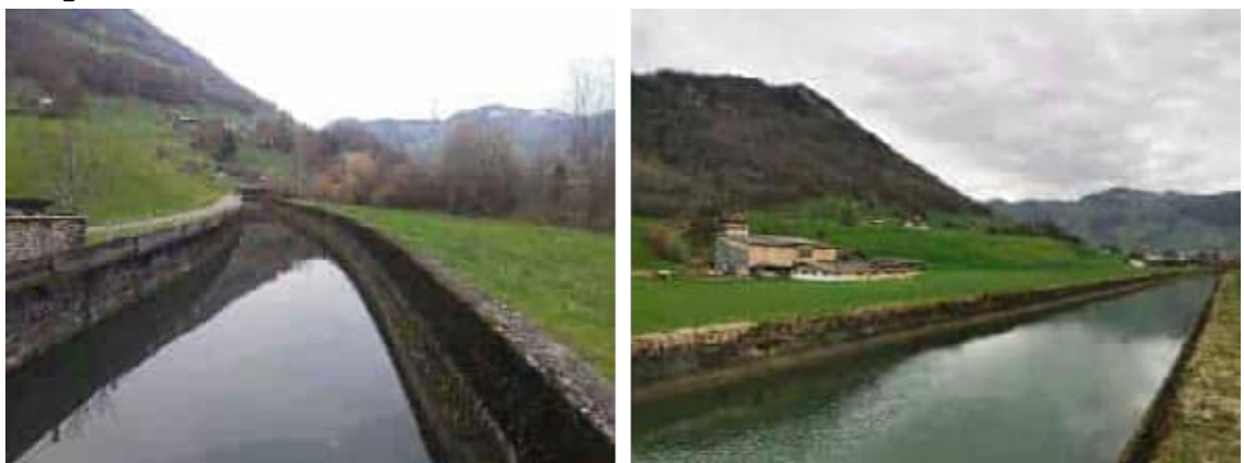
Abbildung 11: Oberwasserkanal, Blickrichtung gegen Fliessrichtung, Fotos: K+Z AG
