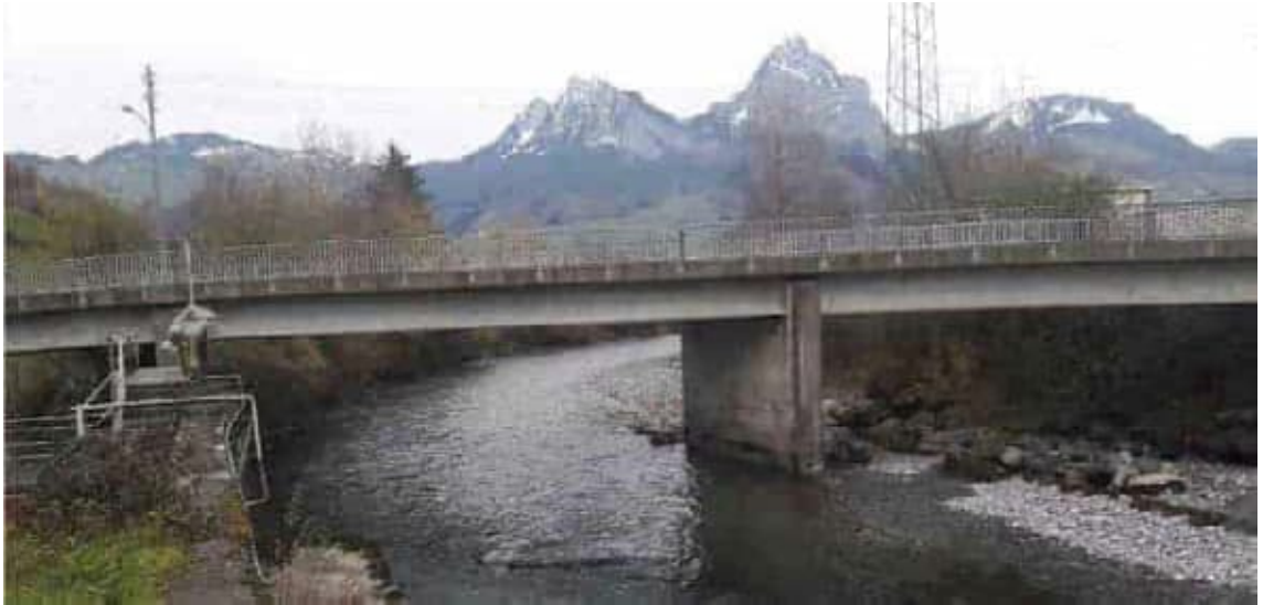
Abbildung 19: Brücke Langesteg, Blickrichtung flussaufwärts, Foto K+Z AG, 2022
