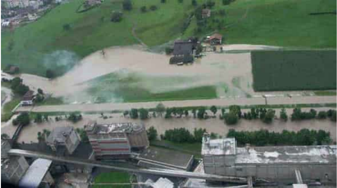
Abbildung 26: Hochwasser am 22./23.08.2005 oberhalb des KW Brunnen. Quelle: Fotoalbum Hochwasser August 2005, Holcim Schweiz AG
