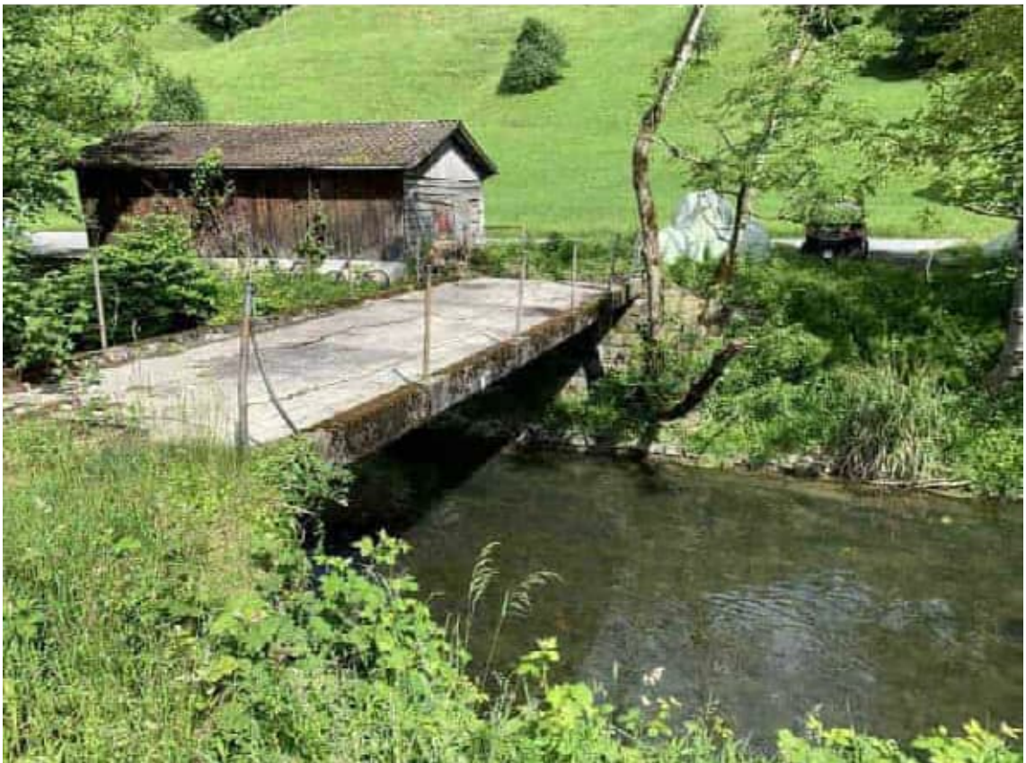
Abbildung 65: Rückzubauende Brücke bei der ARA
