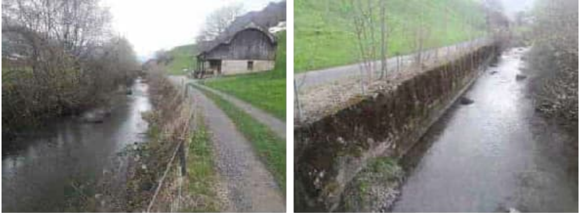
Abbildung 12: Unterwasserkanal, links: Blickrichtung in Fliessrichtung, rechts: Blickrichtung gegen Fliessrichtung, Fotos: K+Z AG
