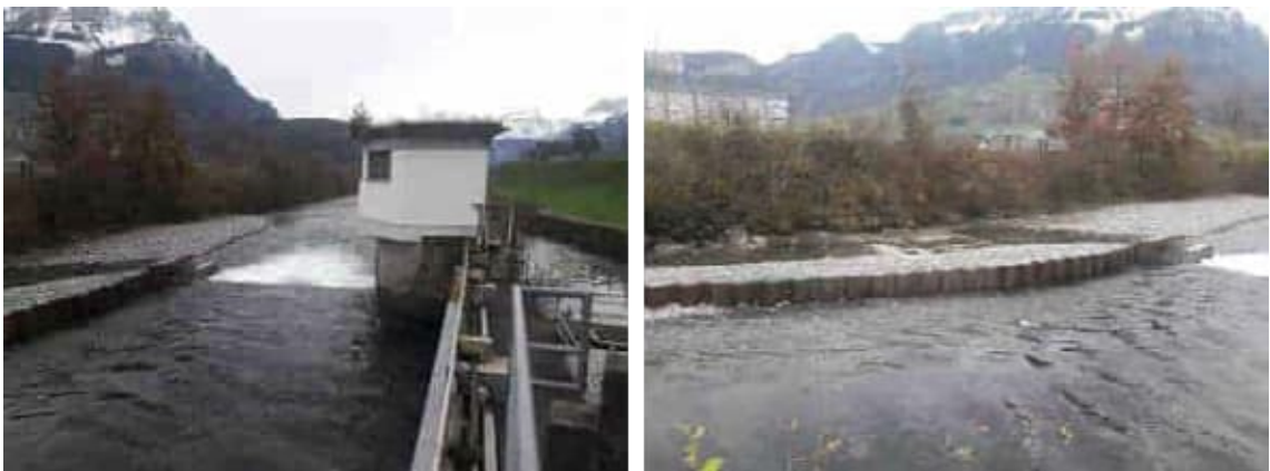
Abbildung 6: Wanderhindernis Wehr KW Brunnen mit einer Spundwandabtrennung zwischen dem Wehr und dem Umgehungsgerinne, Fotos: K+Z AG
