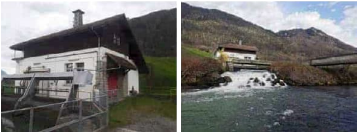
Abbildung 13: Kraftwerksgebäude/ Zentrale KW Brunnen (links) und Wasserrückgabe in die Muota über das Entlastungswehr (rechts), Fotos: K+Z AG, März 2023
