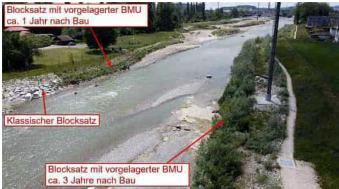
Abbildung 55: Blocksatz und Blocksatz mit vorgelagerter BMU nach ein bis drei Jahre nach Erstellung, Foto: Projekt HWS Emme Solothurn, PG Bau
