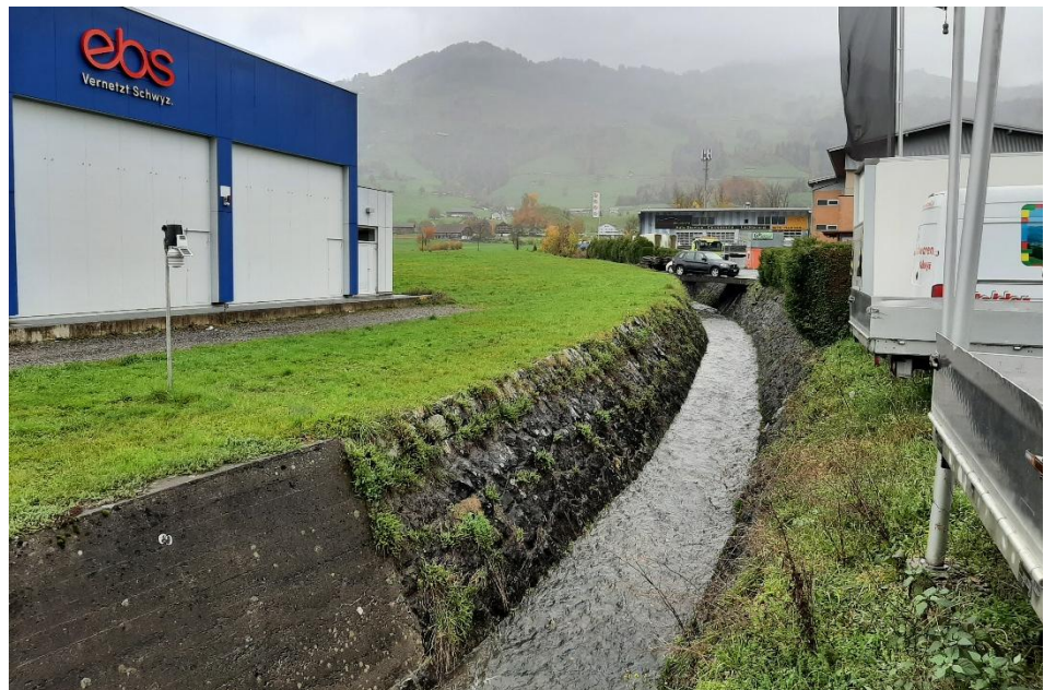
Abbildung 4: Blick am Ende von Abschnitt 1 gegen die Fließrichtung; das Werk der ebs Energie AG ist auf der in Fließrichtung rechten Seite und die Gewerbezone auf der linken Seite, weiter hinten im Bild ist eine der Brücken sichtbar.
