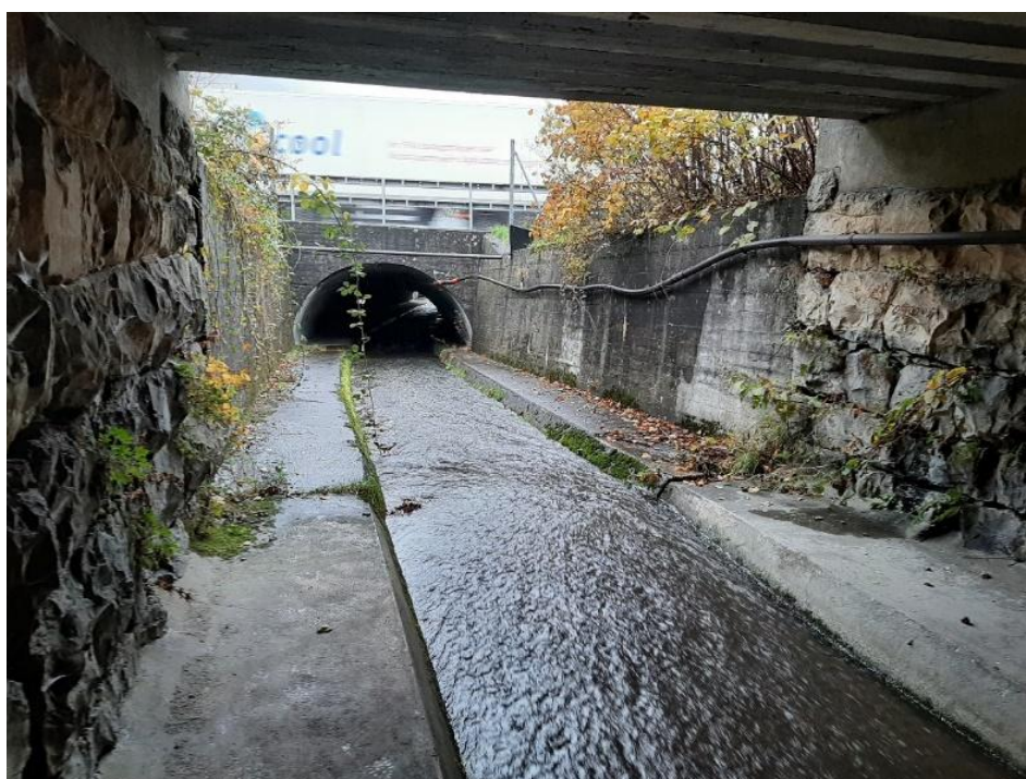
Abbildung 5: Blick aus dem oberen Durchlass in Fliessrichtung gegen den unteren Durchlass hin; der Querschnitt des unteren Durchlasses ist gewölbt und deutlich kleiner als der obere.
