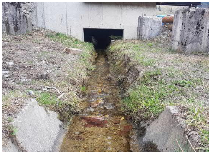
Geissbergbach; Unterlauf, Durchlass unter Sägerei
