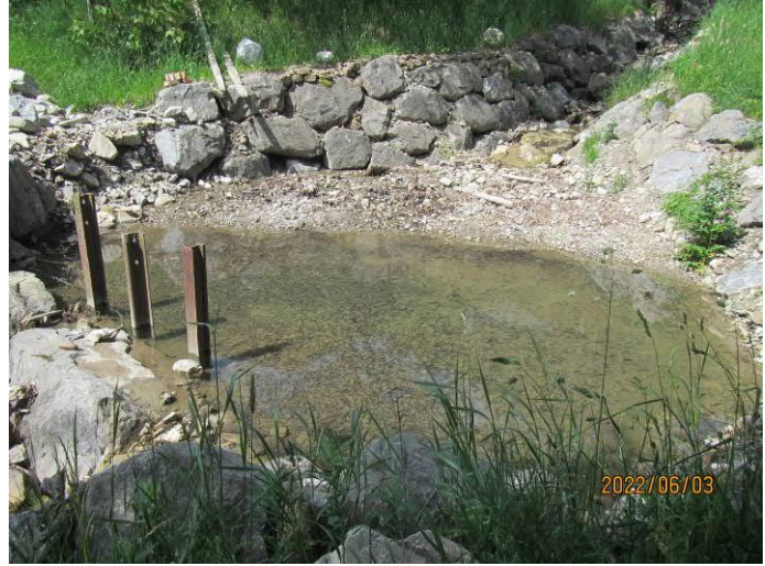
Karlismattbach; Oberlauf, kleiner Geschiebesammler unterhalb Haggeneggweg 4
