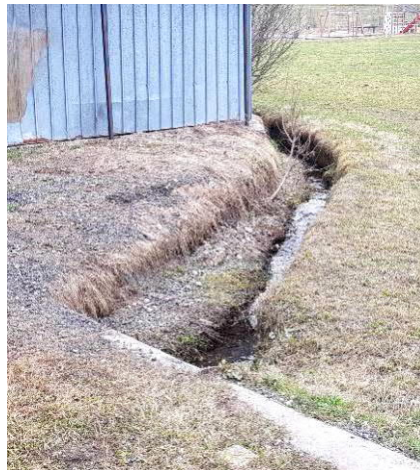
Mattlibach; Unterlauf, unterhalb Dorfstrasse, Auslauf Durchlass in offenes Gerinne
