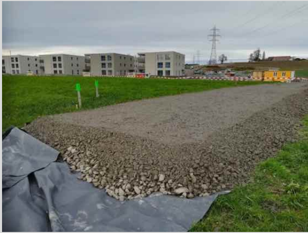
Abbildung 5: Beispielbilder für Boden- und Untergrundabtrag sowie Zwischenlagerung
