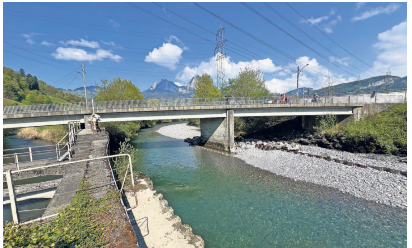
Unter der Langenstegbrücke fliesst die Seewern in die Muota. Künftig soll die Brücke zwischen Brunnen und Seewen nur noch auf einem Pfeiler stehen.
