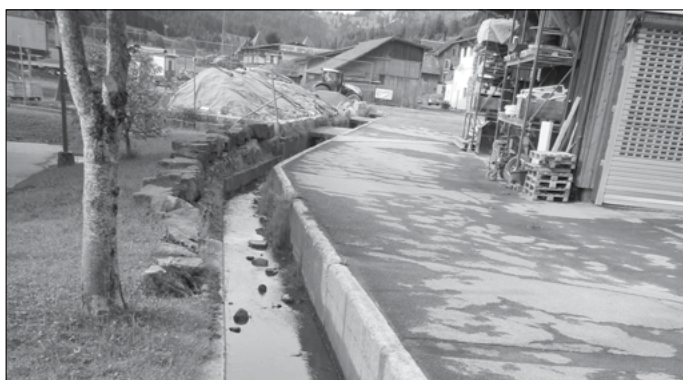
Abbildung 2: Kanalisierter Karlismattbach und Geissbergbach unterhalb Dorfstrasse
