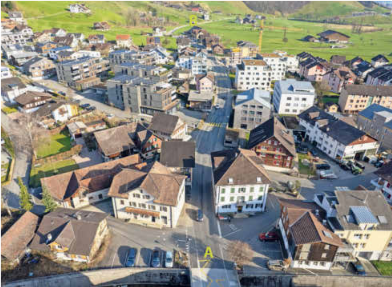
Ab kommendem Montag wird in Steinen die Schwyzerstrasse saniert. Die Arbeiten bewegen sich von der Steiner-Aa-Brücke (A) bis zum Wiler (B). Bild: Erhard Gick
