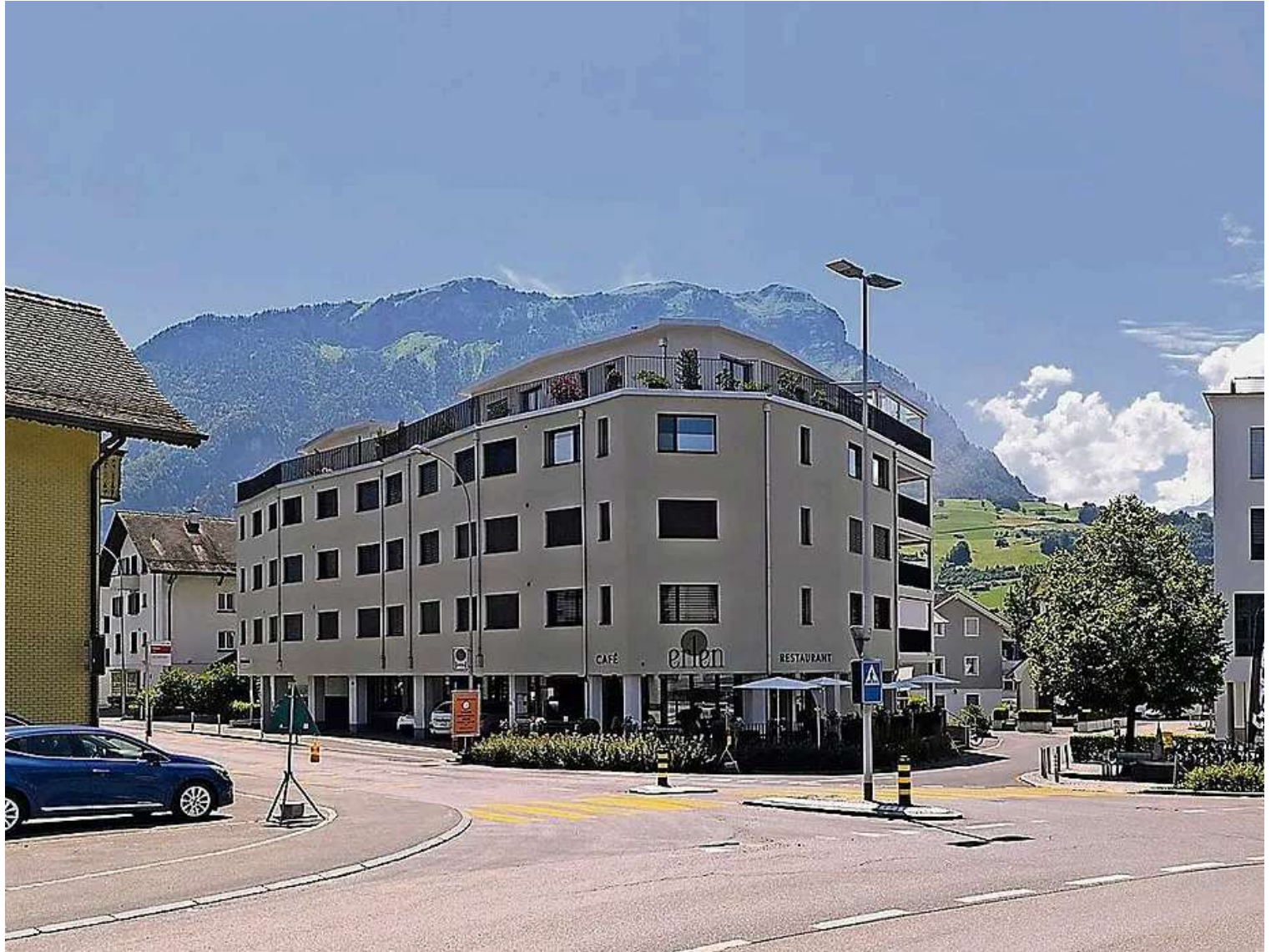
Die Landsgemeindestrasse, die in Ibach am Restaurant Erlen vorbei Richtung Schönenbuch führt, wird saniert. Bild: PD
