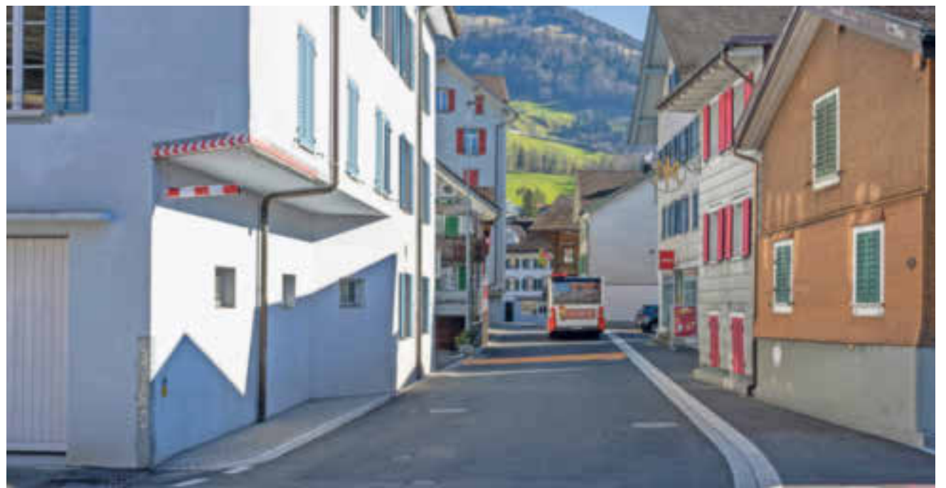
Bis zum Haus Amgwerd (rechts) ist die Sanierung erledigt. Jetzt erfolgt die letzte Etappe im gleichen Standard zwischen «Löwen» und diesem Engpass.
