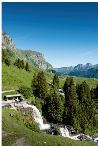
Abbildung 6: Wasserfassung auf der Ruosalp, im Hintergrund das Ausgleichsbecken
