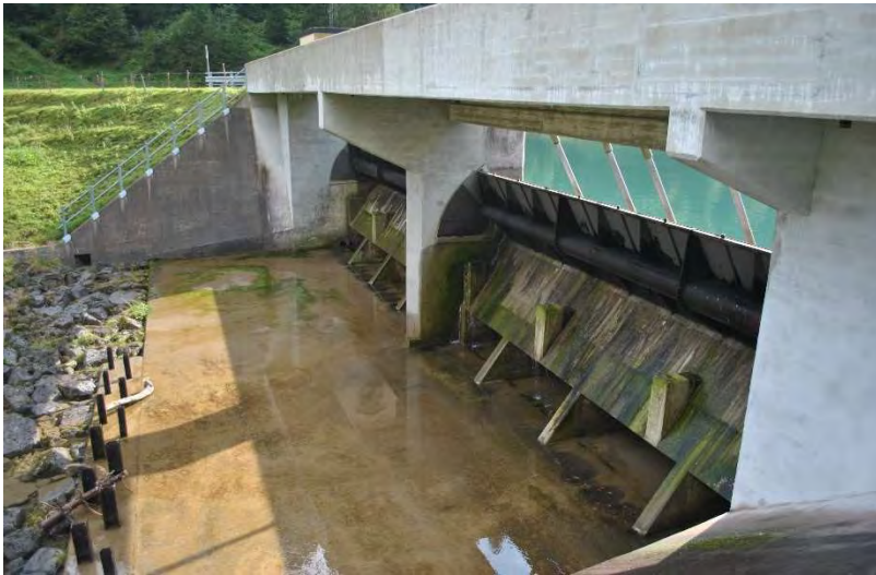
Abbildung 3-3 Ansicht des Stauwehrs und Tosbeckens.
