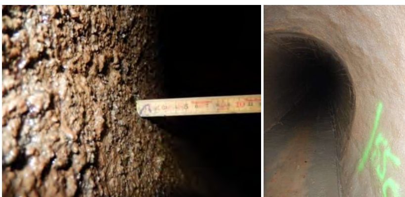
Abbildung 3-7 Typische Oberflächenbeschaffenheit eines mit Gunit ausgekleideten Druckstollenabschnitts (links) und Übergang zwischen einem mit Gunit und einem mit Beton ausgekleideten Druckstollenabschnitt.
