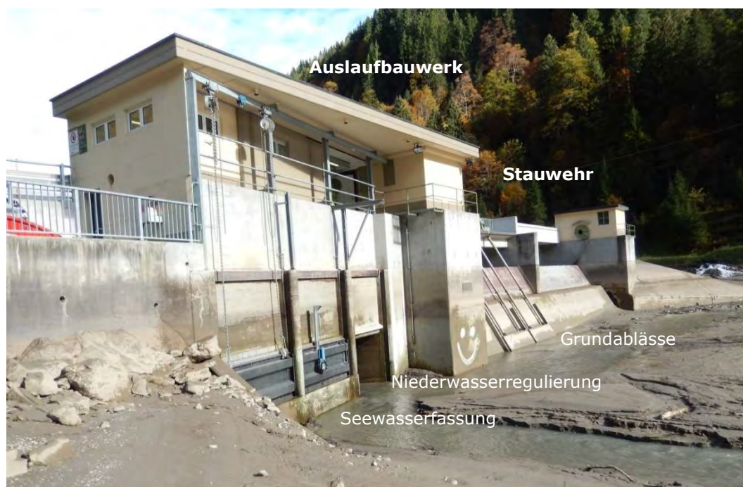
Abbildung 3-2 Ansicht des Auslaufbauwerks und Stauwehrs (Blick in Fließrichtung).
