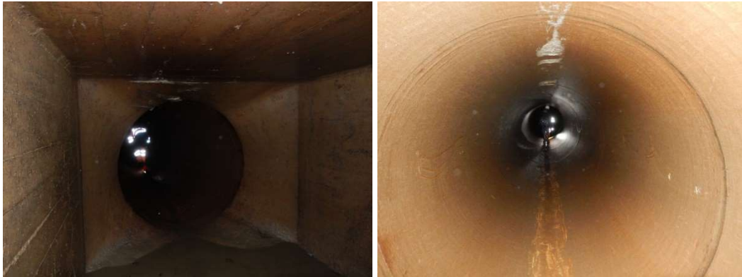
Abbildung 3-6 Übergang vom Betonkanal in die Rohrleitung (links) und Innenansicht der Rohrleitung (rechts).
