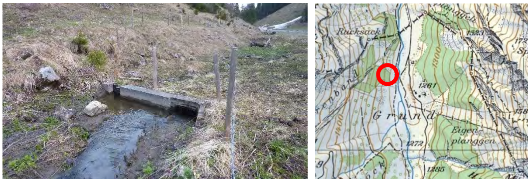
Abbildung 3-2 Fassung Flöschen (Foto: ebs Energie AG).
