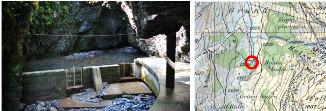
Abbildung 3-1 Fassung Grund (Foto: AFRY Schweiz AG).
