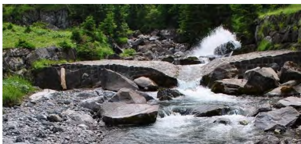
Abbildung 3-5 Messschwelle oberhalb der Fassung Lipplisbüel (Foto: AFRY Schweiz AG).
