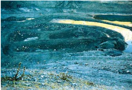
Abbildung 6-14 Dämme im Bereich der Seewasserfassung (Foto: ebs Energie AG).
