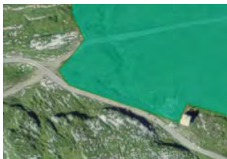
Abbildung 6-2: An die Zufahrtstrasse angrenzendes Schutzgebiet (Flachmoor 2709).
