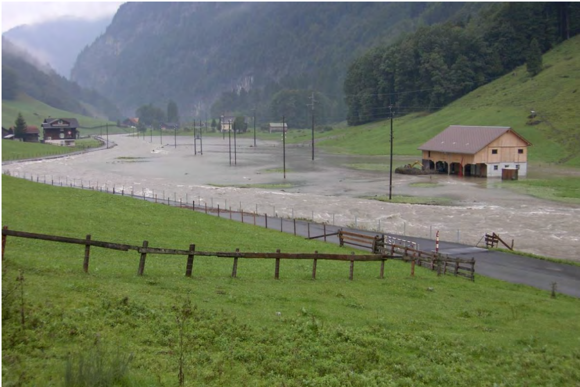
Abbildung 4: Riedblätz bei Hochwasser – Bild in Fliessrichtung der Muota (Haus links der Muota befindet sich am Ende der geplanten Teilabdichtung).
