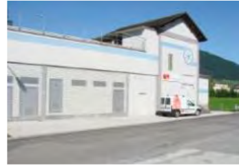
Abbildung 4: KW Ibach - Kraftwerksgebäude
