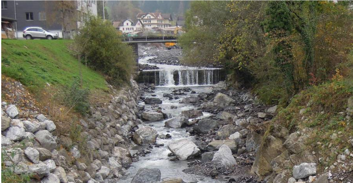
Abbildung 24: Absturz beim Sammlerauslauf (Blick bergwärts; Aufnahme 2012)
