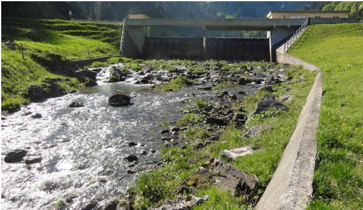
Abbildung 15: Unterlauf KW Sahli (Aufnahme Mai 2017)
