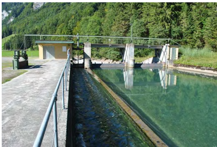
Abbildung 3-2 Bestehendes Stauwehr und Fassung Muota (Blick in Fließrichtung).
