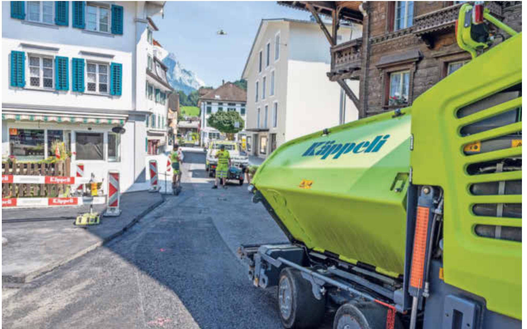
In Steinen wird die Herrengasse/Schwyzerstrasse saniert. Für die Abschlussarbeiten ist die Strasse komplett gesperrt.
