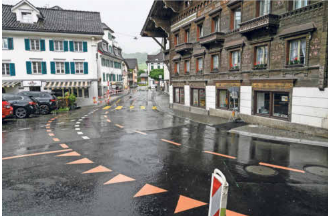
Am Montag wird in Steinen im Abschnitt «Rössli» (im Bild rechts) Dorfplatz bis Dorfbrücke mit der dritten Sanierungsetappe begonnen.
