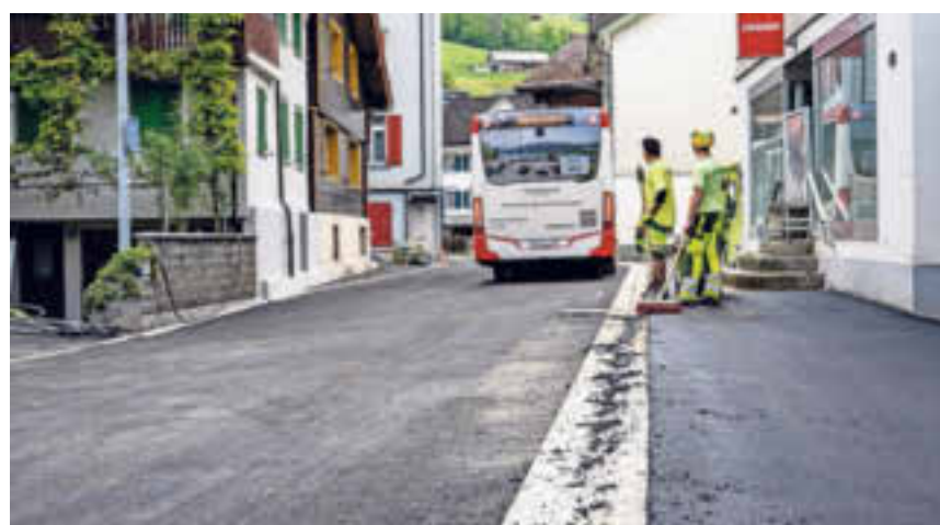
Die zweite Bauetappe steht kurz bevor. Die Auto AG Schwyz testete gestern mit einem Gelenkbus die künftige Baustellen-Durchfahrt und brachte Bodenmarkierungen für die Chauffeure an.
