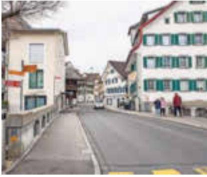
Ab der Dorfbrücke bis zum ehemaligen «Löwen» wird saniert. Bild: Erhard Gick
