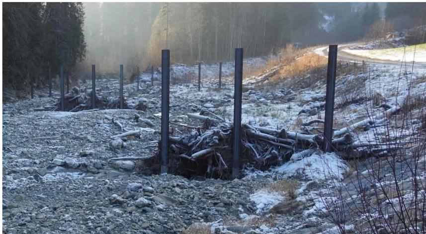
*Abbildung 11: Selektiver Schwemmholzurückhalt an der Minster bestehend aus total 6 Einzelrechen (Blick bergwärts, Aufnahme Nov 2020)*
