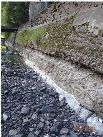
*Ufermauer mit auserodiertem, altem Stampfbeton (linksufrig)*
