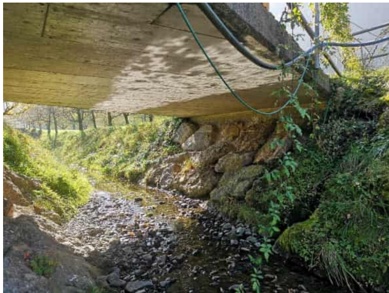
Abbildung 18: Durchlass 4, linke Seite (Blickrichtung bachaufwärts)
