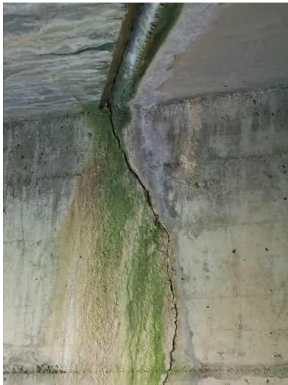
Abbildung 34: Durchlass Autobahn Bollenwaldbach, rechte, obere Ecke
