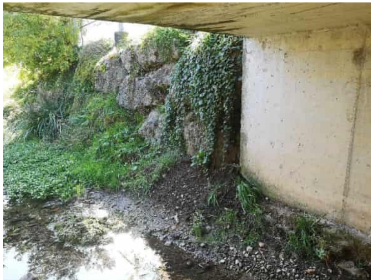
Abbildung 23: Durchlass 5, linke Seite (Blickrichtung bachaufwärts)
