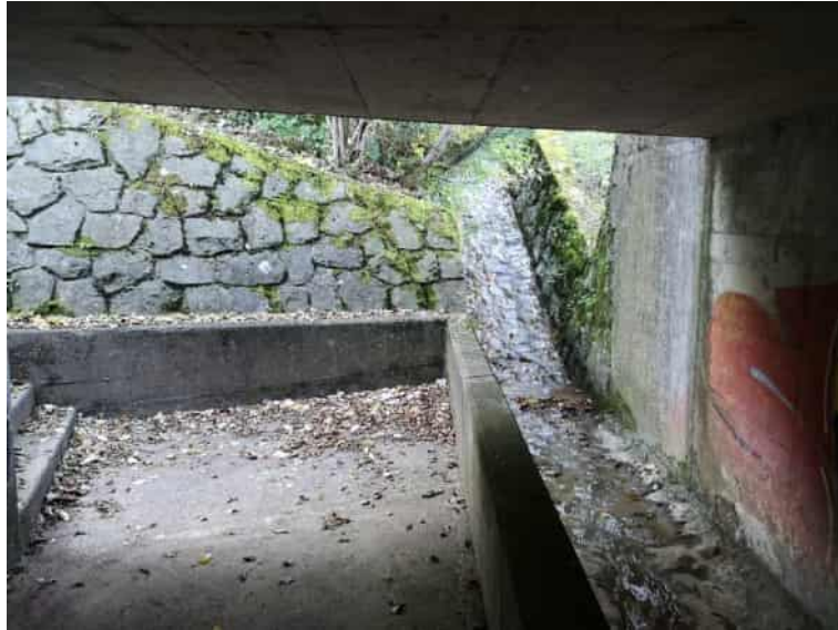
Abbildung 31: Anfang Durchlass Autobahn Mühlebach (Blickrichtung bachaufwärts)
