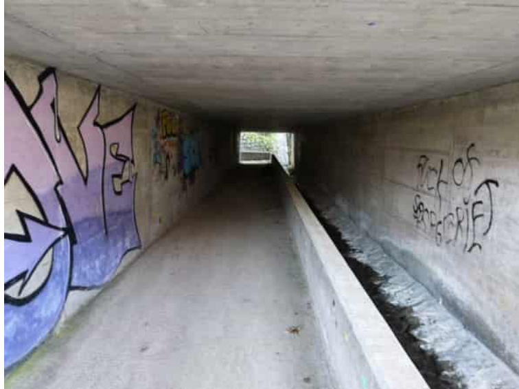
Abbildung 32: Durchlass Autobahn Mühlebach (Blickrichtung bachaufwärts)
