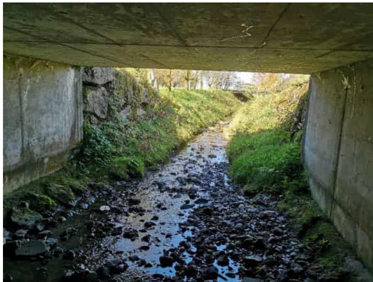
Abbildung 21: Durchlass 5, Ende des Durchlasses
