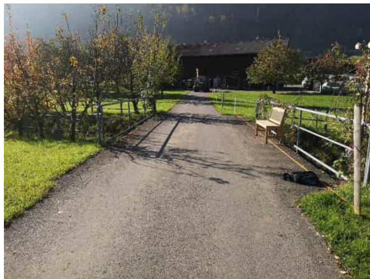
Abbildung 16: Brücke beim Durchlass 4 (Blickrichtung Südwesten)
