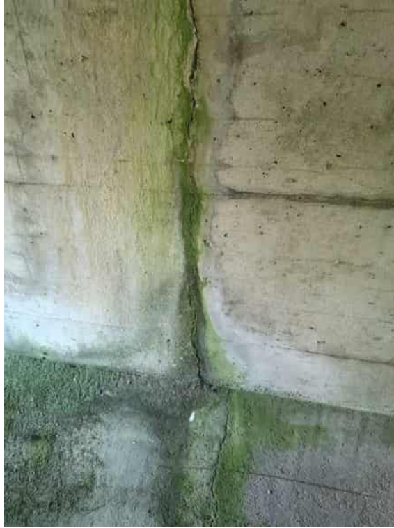
Abbildung 35: Durchlass Autobahn Bolliwaldbach, rechte, untere Ecke
