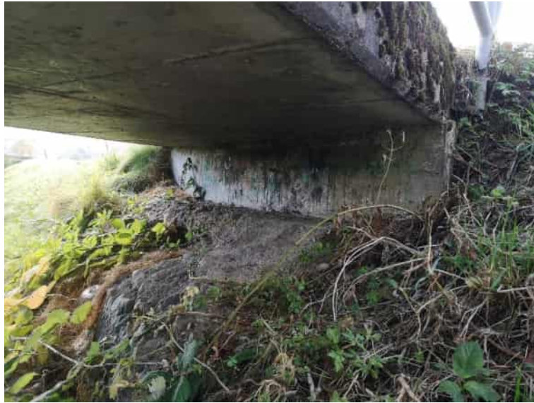
Abbildung 11: Durchlass 2. linke Seite (Blickrichtung bachaufwärts)
