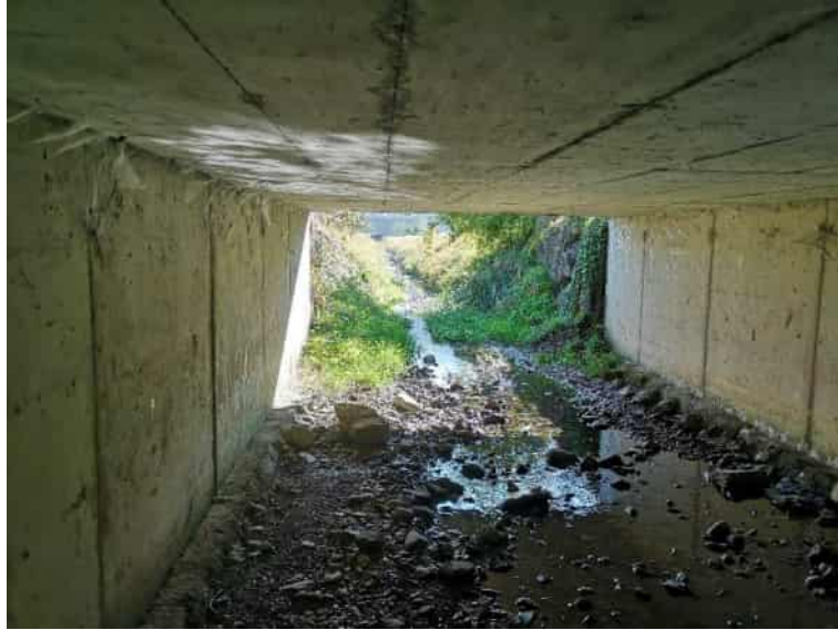
Abbildung 20: Durchlass 5, Anfang des Durchlasses (Blickrichtung bachaufwärts)
