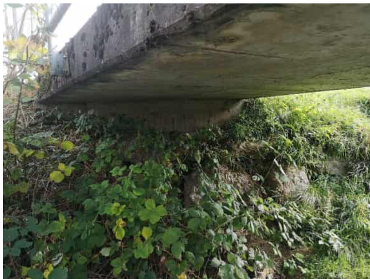
Abbildung 12: Durchlass 2, rechte Seite (Blickrichtung bachaufwärts)
