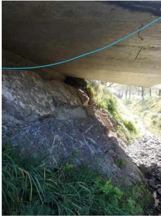
Abbildung 17: Durchlass 4, rechte Seite (Blickrichtung flussaufwärts)
