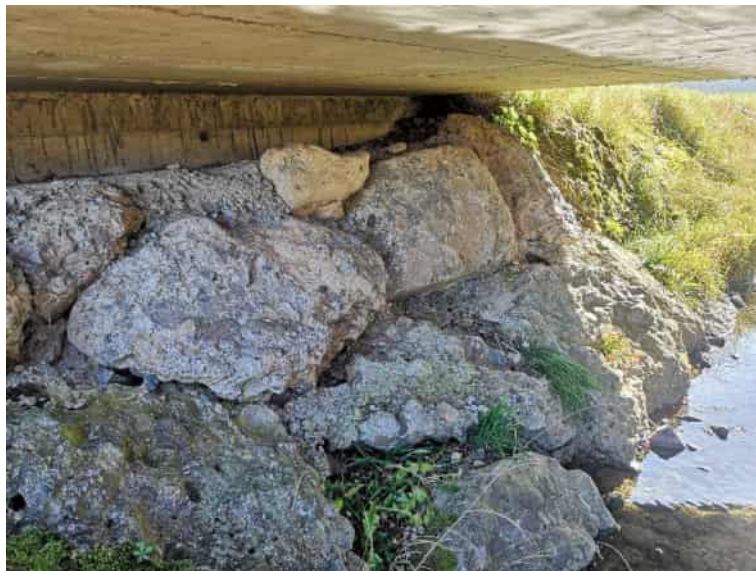
Abbildung 26: Durchlass 6, rechte Seite (Blickrichtung bachaufwärts)
