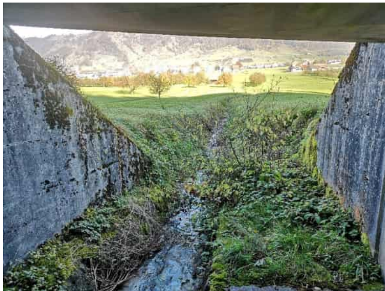
Abbildung 36: Ende Durchlass Autobahn Bolliwaldbach
