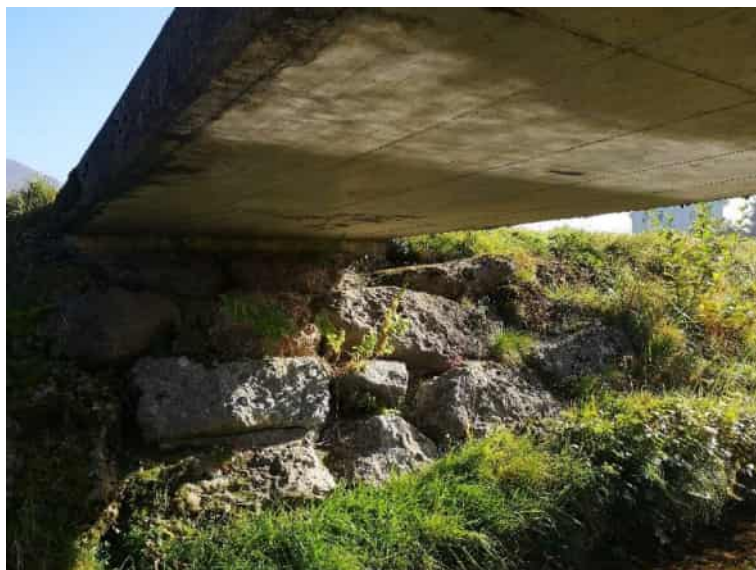
Abbildung 15: Durchlass 3, rechte Seite (Blickrichtung bachaufwärts)
