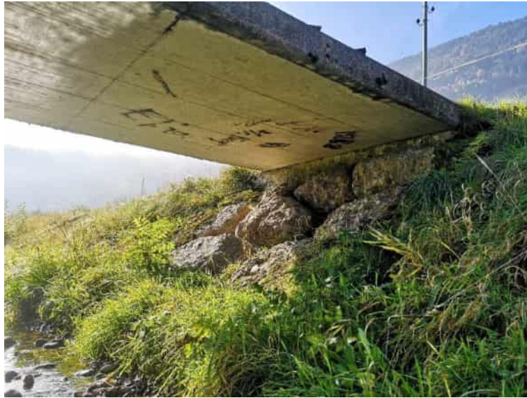
Abbildung 14: Durchlass 3, linke Seite (Blickrichtung bachaufwärts)
