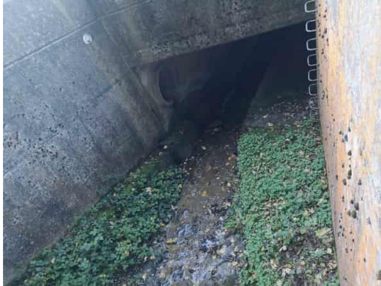
Abbildung 33: Anfang Durchlass Autobahn Bollenwaldbach
