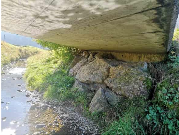
Abbildung 25: Durchlass 6, linkes Ufer (Blickrichtung bachaufwärts)
