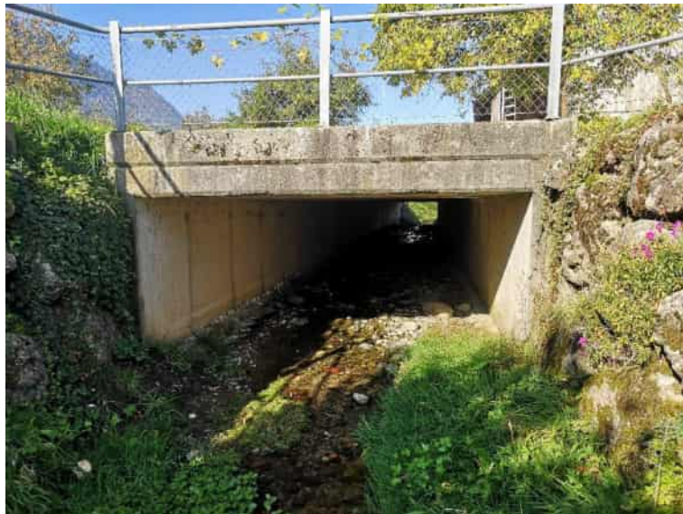
Abbildung 19: Durchlass 5, Anfang des Durchlasses
