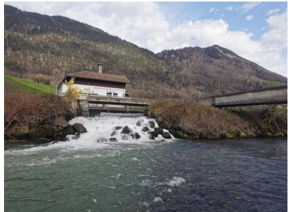
Abbildung 11: Kraftwerksgebäude/ Zentrale KW Brunnen (links) und Wasserrückgabe in die Muota über das Entlastungswehr (rechts), Fotos: K+Z AG, März 2023
