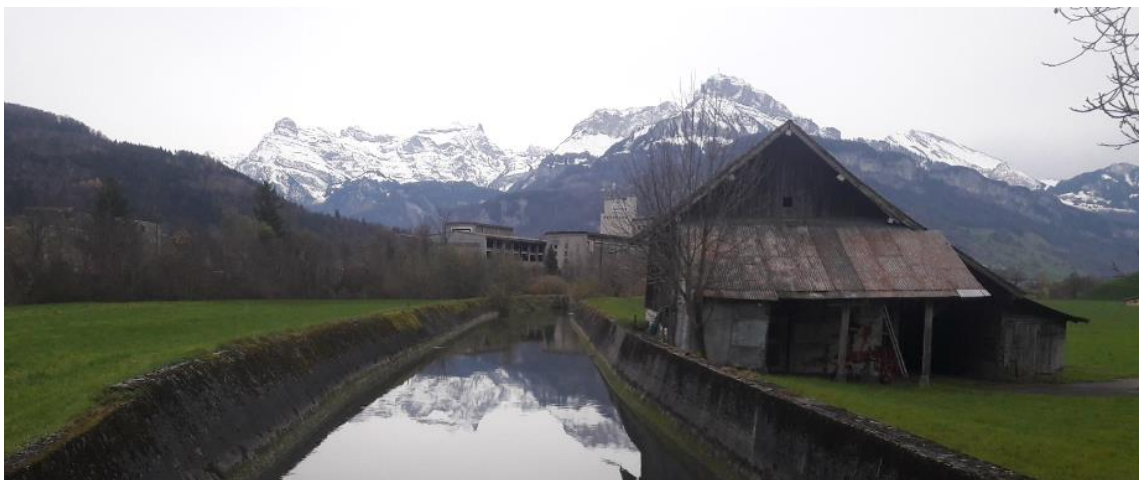
Abbildung 13: landwirtschaftliches Gebäude direkt am rechten Ufer des Oberwasserkanals zwischen Gewässernr. 2642 und 2527, Foto: K+Z AG
