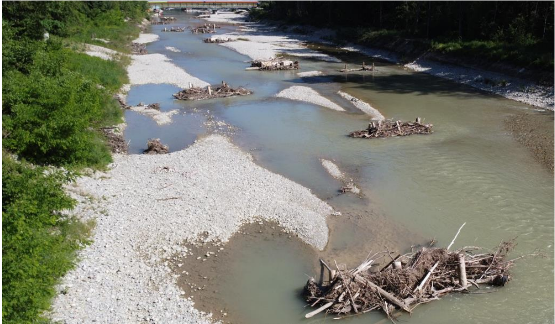
Abbildung 43: Beispielbild von eingebauten Totholzinseln an der Emme in Solothurn, Quelle: Projekt HWS Emme Solothurn, PG Bau
