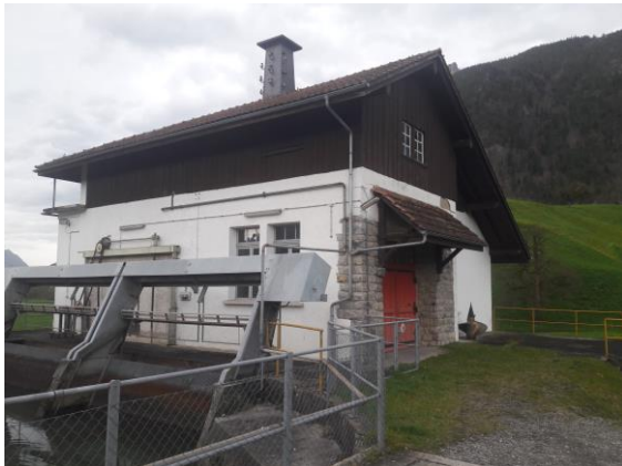
Abbildung 11: Kraftwerksgebäude/ Zentrale KW Brunnen (links) und Wasserrückgabe in die Muota über das Entlastungswehr (rechts), Fotos: K+Z AG, März 2023
