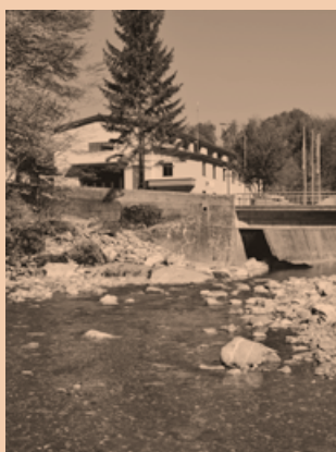
Seit 50 Jahren im Einsatz: das Wasserkraftwerk Wernisberg.
