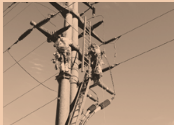
Die EBS-Netzelektriker haben viele Leitungen erneuert.
