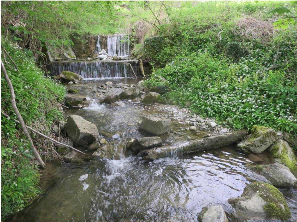
*Abbildung 1: Defekte Schutzbaute (Holzschwelle) am Rätigsbach*
