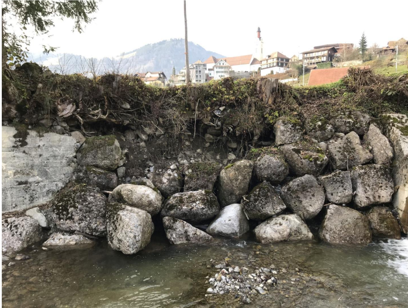
Schadhafte Ufermauern
