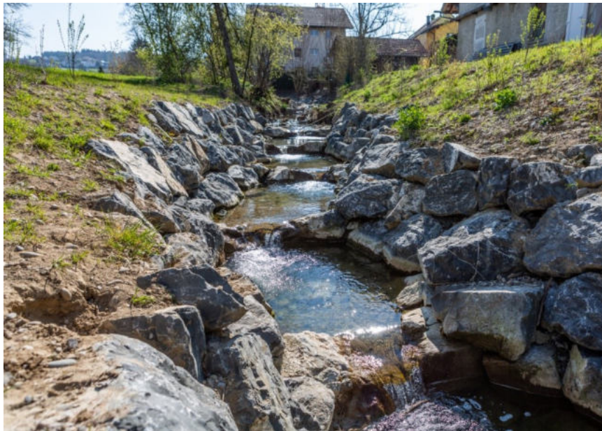
Beispielbild Blockriegel und Ufersicherung
