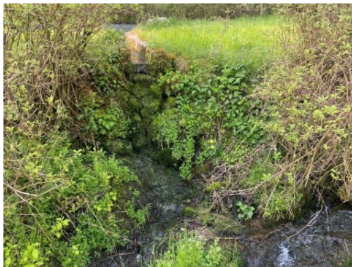
Absturz beim Auslass des Weihers
