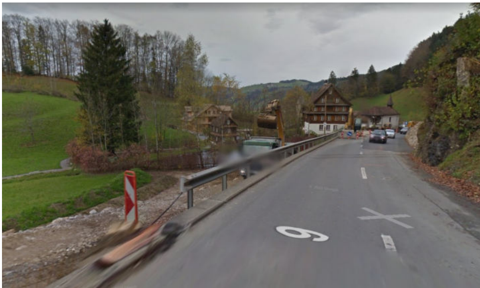
Abbildung 6: Kantonsstrasse vor Erstellung der Stützmauer (Foto: Google Street View)
