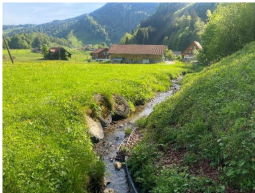
Abschnitt oberhalb der Fischzucht mit nicht fachmännischem Uferverbau
