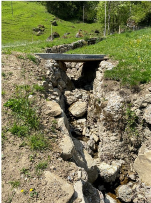
2021 erstellter Uferverbau mit Übergang
