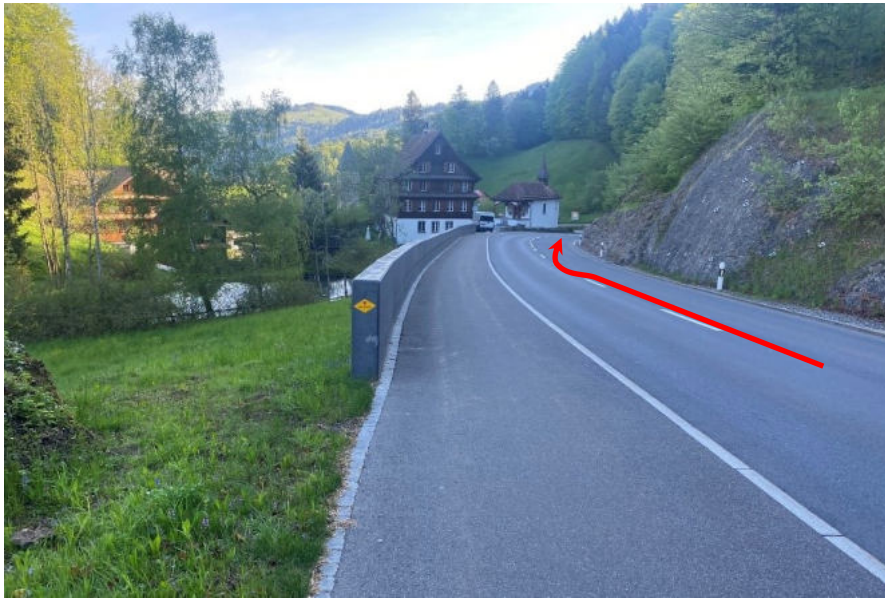
Abbildung 5: Kantonsstrasse mit Stützmauer und mit Fließrichtung des Oberflächenwassers in rot (Foto: HOLINGER AG)
