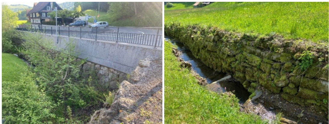
Abbildung 3: Ufer-/ Stützmauer entlang der Kantonsstrasse, Ufer-/Sohlverbau am Niederistmattbach (Fotos: HOLINGER AG)
