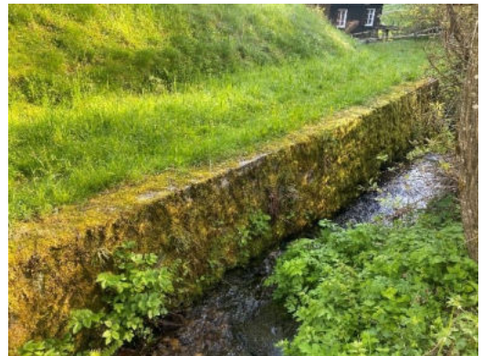
Ufermauer entlang dem Weiher
