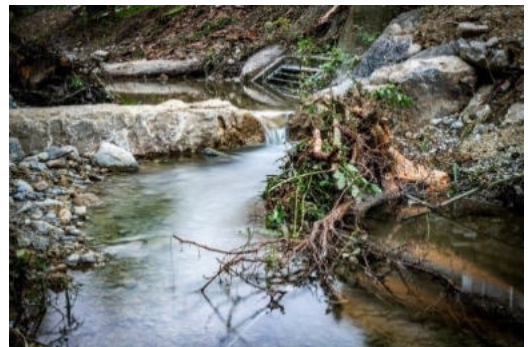
Beispielbild Gerinnestrukturierung mit ingenieurbioologischen Elemente (HOLINGER AG)
