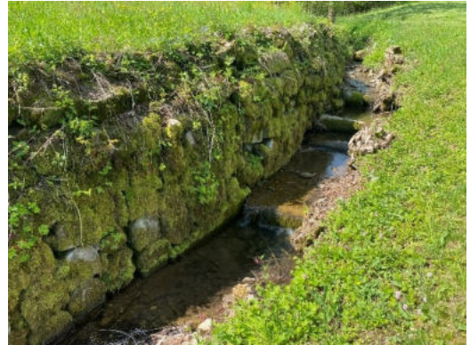
Uferverbau aus Blocksätzen, Sohlverbau aus Holzschwellen rund 40 m oberhalb der Eindolung
