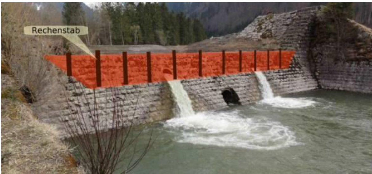
Abbildung 34: Abschlussperre mit Teilrückbau und Schwemmholzrechen
