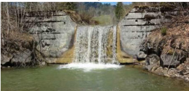
Absturzbauwerk eingangs Geschiebesammler
