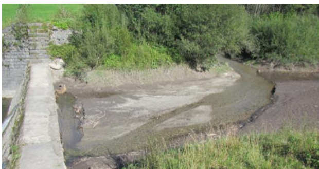
Aufnahme dat. 23.09.2021 oberhalb Geschiebesammler Abbildung 21: Geschiebesammlersperre Ochsenboden
